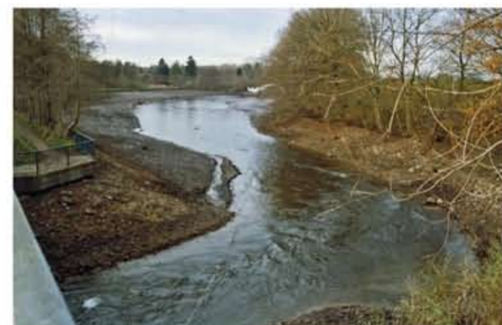
Blick aus Richtung B 202: Verlauf der Schwentine nach Ablassen des Wassers aus dem Rosensee (2004)
